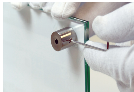
Glasscheiben an Abstandshalter (an der Wand) festschrauben
