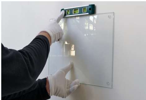
4 Löcher anzeichnen und bohren
