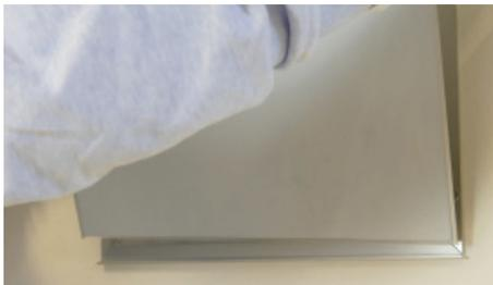
Schild auf den unteren Schenkel aufsetzen und ausrichten
